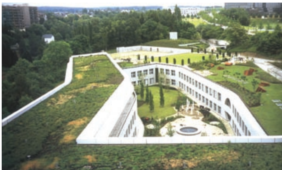
7. Bei Lussemburgo: i giardini pensili e le coperture a verde estensivo dei tetti
